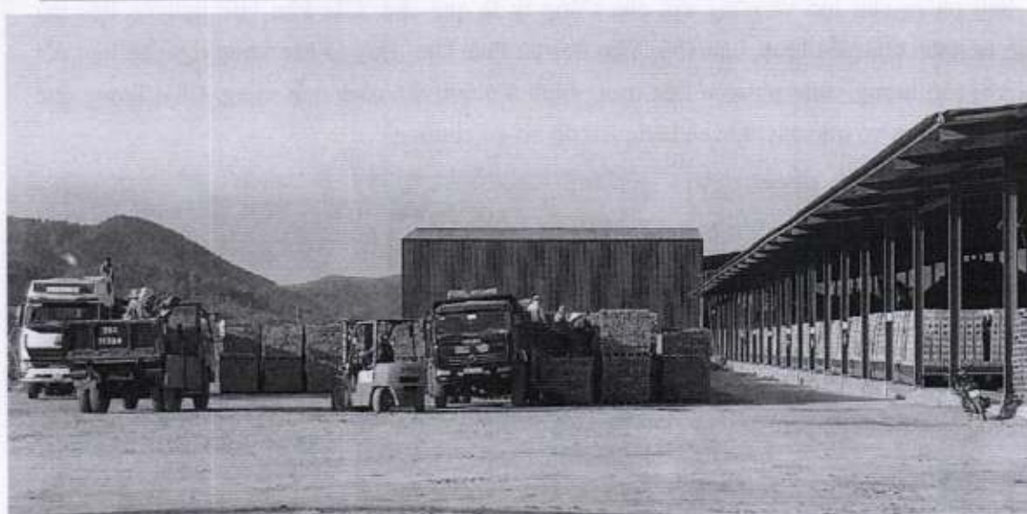
Hình ảnh phía tây nhà máy gạch Tuynel Hậu Lộc – Thanh Hóa
